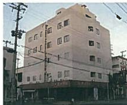
津波避難ビル
